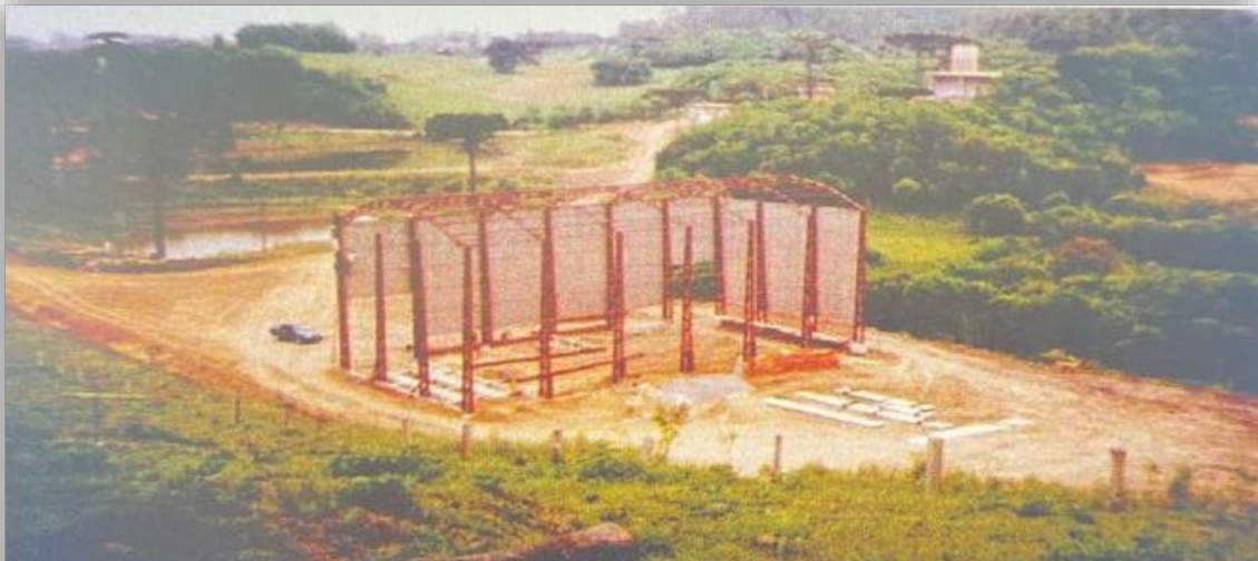
Início da construção da fábrica de rações em Farroupilha/RS em 1998
